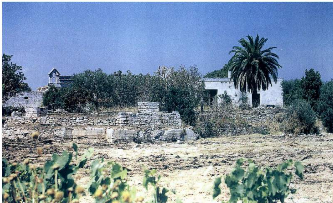
1 - Resti di un casale in zona Arco Camerata (foto E. Varricchio)
