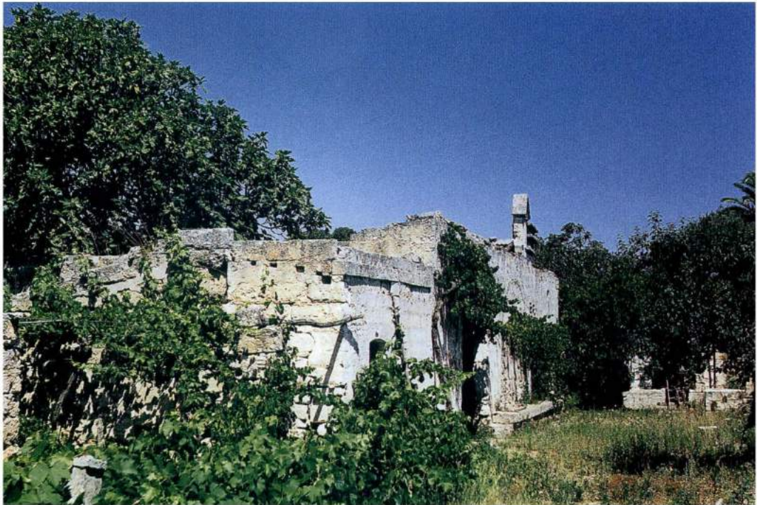
3 - Resti di un casale in zona Arco Camerata (foto E. Varrichio)
